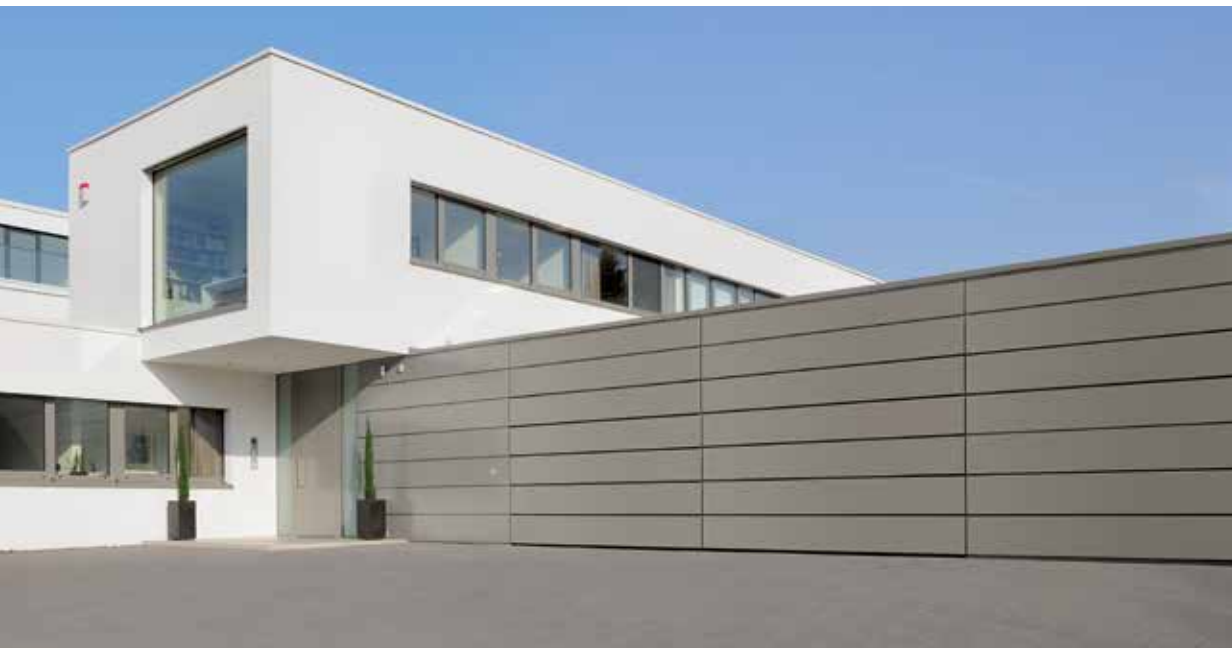
Kohapeal paigaldatav alumiinium-komposiitmaterjalist vooder
