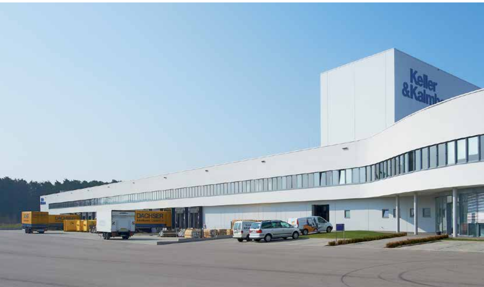
Keller & Kalmbach GmbH, Hilpoltstein, Hörmanni toodetega hoone
